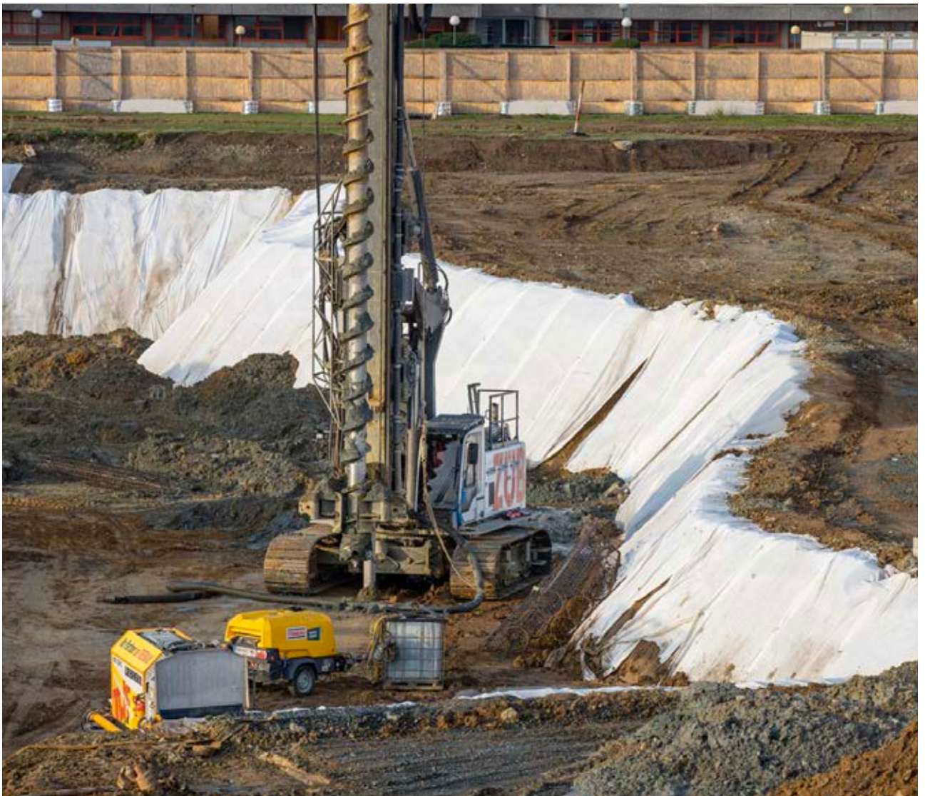
Das LB 28 und die Liebherr-Betonpumpe THS 110 von Züblin Spezialtiefbau Ges.m.b.H. auf der Baustelle in Oberwart.
