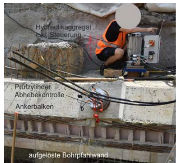
Abb. 4: Erprobung eines neuen Prüfequipments für Abhebekontrollen an einer Baugrubensicherung
