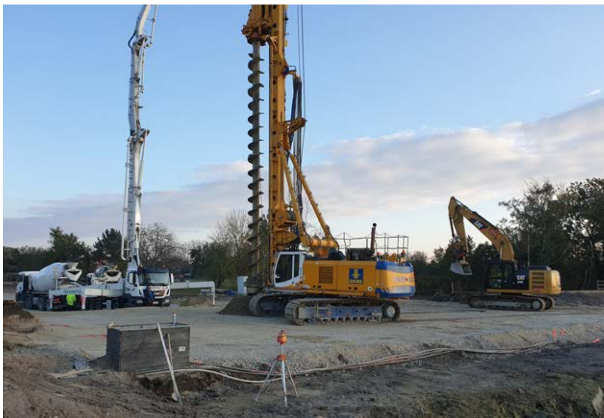
BAUER BG 28 – Arbeiten während einer Gleissperre (Unterführung Bahnhof Untersiebenbrunn)
