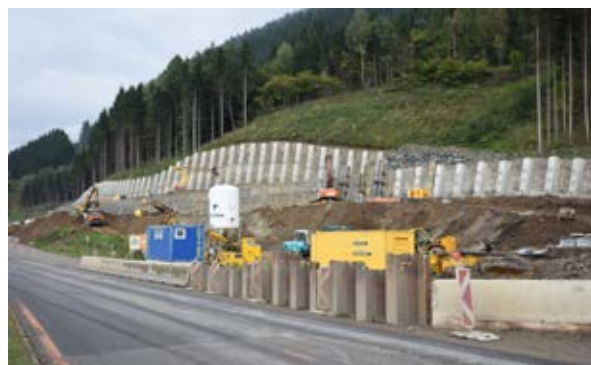
Abb. 1: Ankerwand entlang einer Verkehrsstrasse
